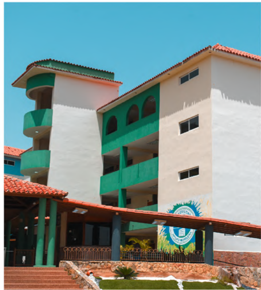
Facultad de Ingeniería | Edificio Verde
